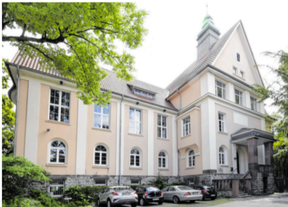
Der Altbau des Walram-Gymnasiums wurde mit der Schulfusion im Jahr 2015 umgebaut. Dafür musste das Brandschutzkonzept überarbeitet werden und bis zur Eröffnung umgesetzt sein. Die Überarbeitung der Flucht- und Rettungspläne wurde erst ein Jahr später in Auftrag gegeben.
